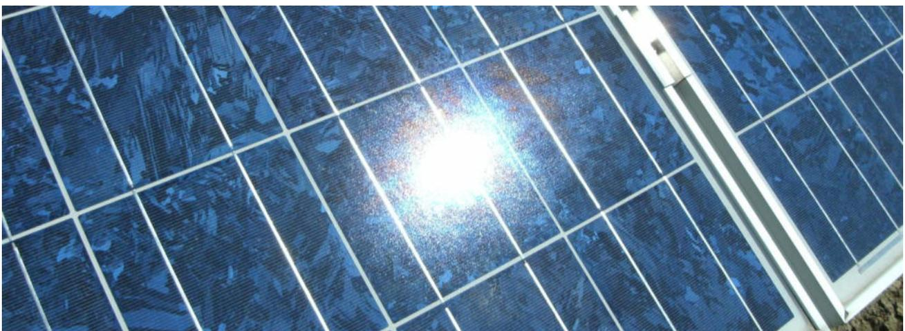
Bild 3.2.2: Diffuse Reflexion von direkten Sonnenlicht (Einstrahlung ca. 980 W/m<sup>2</sup>) auf einem PV-Modul (Quelle: SolPEG)
