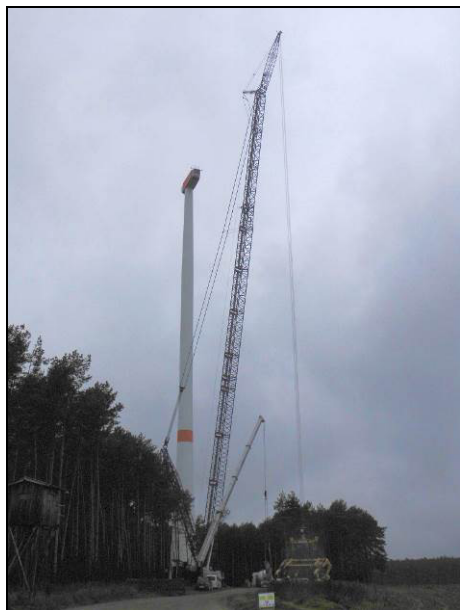
Abb. 13 WEA 2 im Bau (10/2016)
