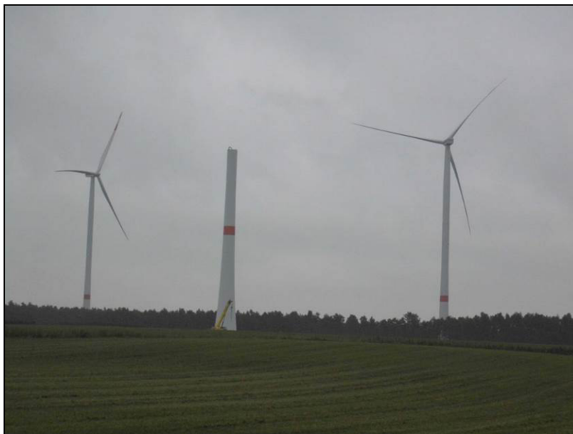
Abb. 14 WEA 7 im Bau - dazu 2 WEA im Wahlsdorfer Teil des WEG (10/2016)
