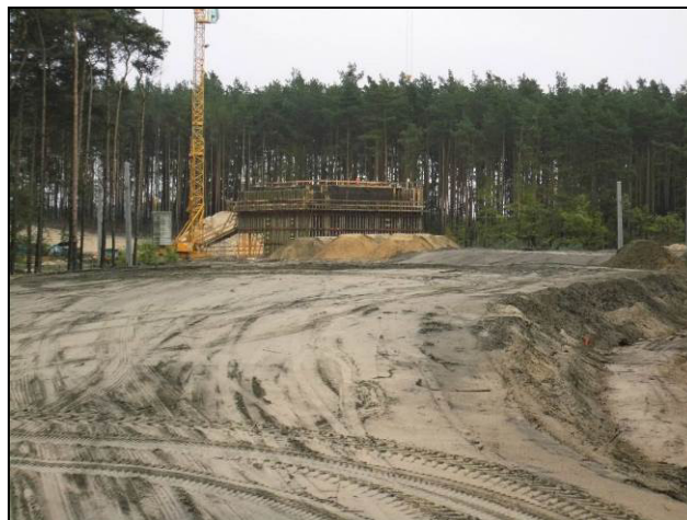
Abb. 43 Eisenbahnbrücke Klein Ziescht (10/2016) - im Bau bis 2017
