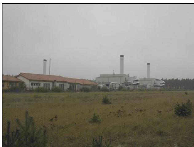
Abb. 30 Gas-Verdichterstation Radeland - D6
