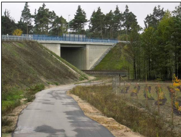
Abb. 42 Eisenbahnbrücke Mückendorf - fertig gestellt 2015
