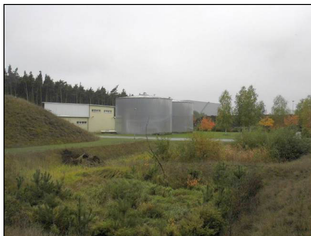
Abb. 32 Betriebsgelände Rohwasserwerk östlich IG Bernhardsmüh
