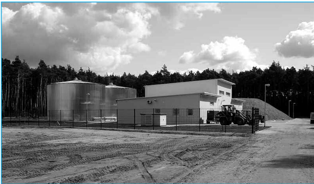
Im Bereich des Industriegebietes Bernhardsmüh wurde das neue Rohwasserwerk fertig gestellt. Das Rohwasserwerk versorgt das Industriegebiet Bernhardsmüh mit Brauch- und Kesselspeisewasser. Täglich können bis zu 2.000 m<sup>3</sup> Wasser zur Verfügung gestellt werden.
