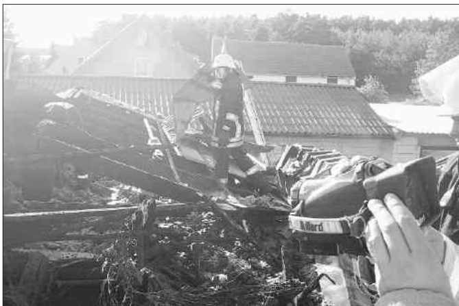
Mittels einer Wärmebildkamera (rechts) konnten gezielt Glutnester gefunden werden.
