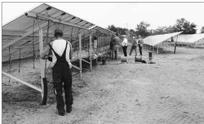
Eindrücke vom Solarpark
