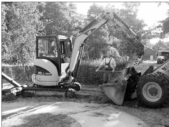
Die Arbeiten am Spielplatz gehen zügig voran Fotos: Kita Baruth/M.
