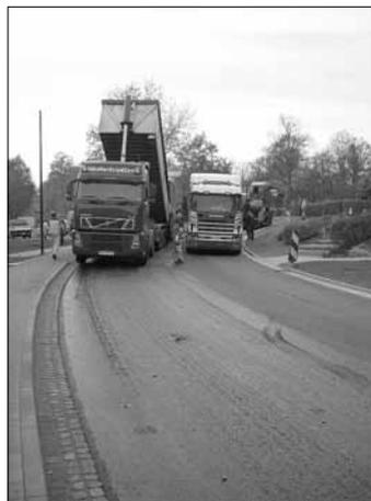
Aufbringen der Verschleißschicht auf beide Fahrbahnhälften
