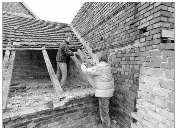
Die alten Biberschwanz-Dachsteine werden gesichert für unser Gutsarbeiter-Grundstück
