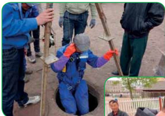
oben links: Absicherung Reinigung Abwasserkanal im Mai 2016
