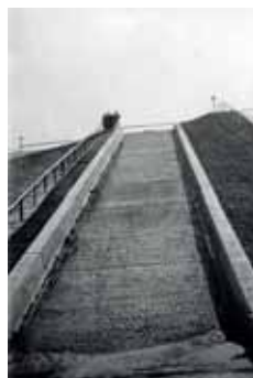
Osterfest 1942: Ansicht der 45 %-Steigungsbahn von Horstwalde noch mit Treppenanlage
