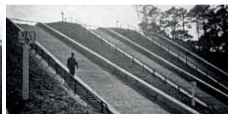
Osterfest 1942: Ansicht der Steigungsbahnen 45 %, 55 % und 65 % von Horstwalde noch mit Treppenanlagen
