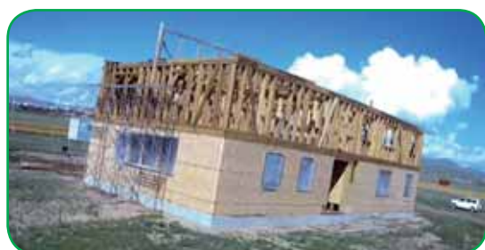
Der momentane Baufortschritt (Stand 08.08.2018) des Schulungszentrums in der Partnerstadt Murun (Mongolei) Foto: Stadt Baruth/Mark
