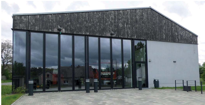
Foto: das neu errichtete Feuerwehrgerätehaus der Ortswehr Merzdorf
