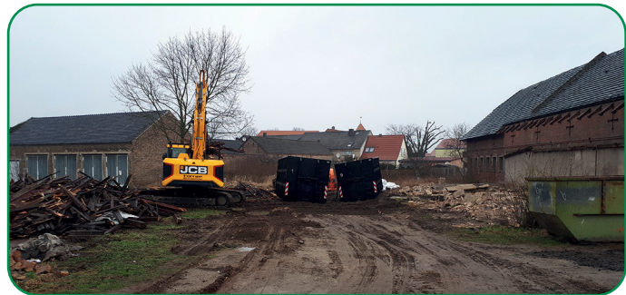
Foto: Baugelände KITA Paplitz
