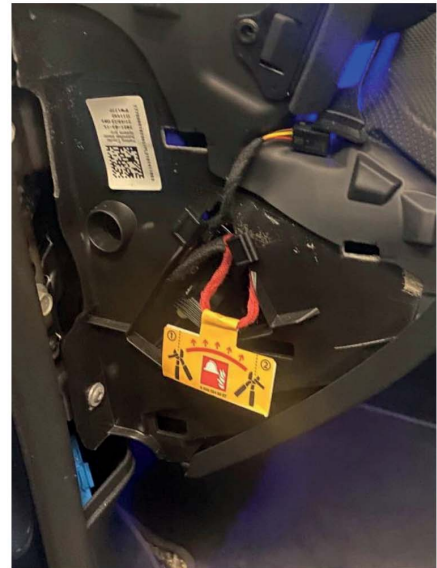
Sicherung für die Feuerwehr
