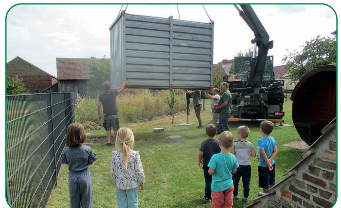
Bild: Kita Groß Ziescht „Spannung beim Abladen des Containers“
