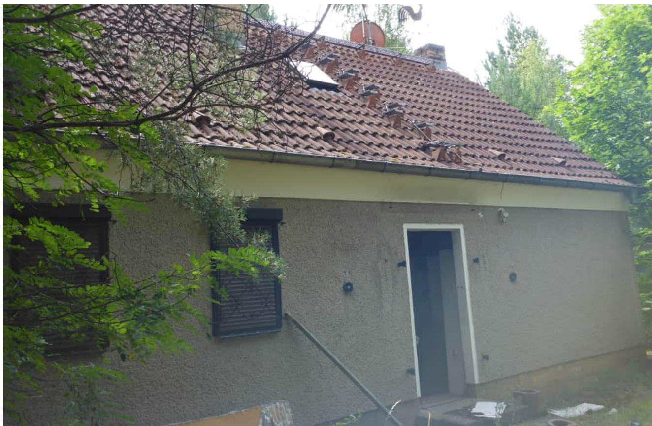
Abbildung 13: Wohngebäude Gartenansicht, Gemarkung Mückendorf, Flur 3 FS Teupitzer Weg Hausnr.
