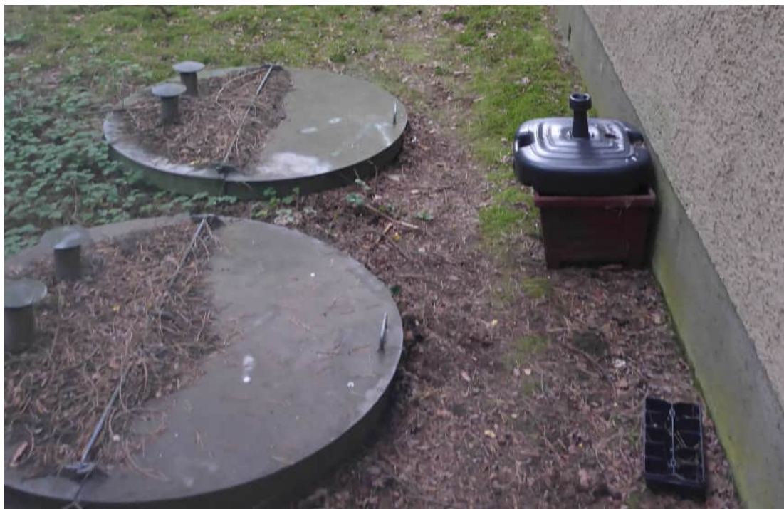
Abbildung 18: Schächte am Wohngebäude, Gemarkung Mückendorf, Flur 3 FS Teupitzer Weg Hausnr.
