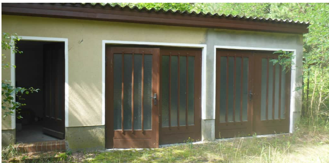
Abbildung 14: Nebengebäude, Gemarkung Mückendorf, Flur 3 FS Teupitzer Weg Hausnr.
