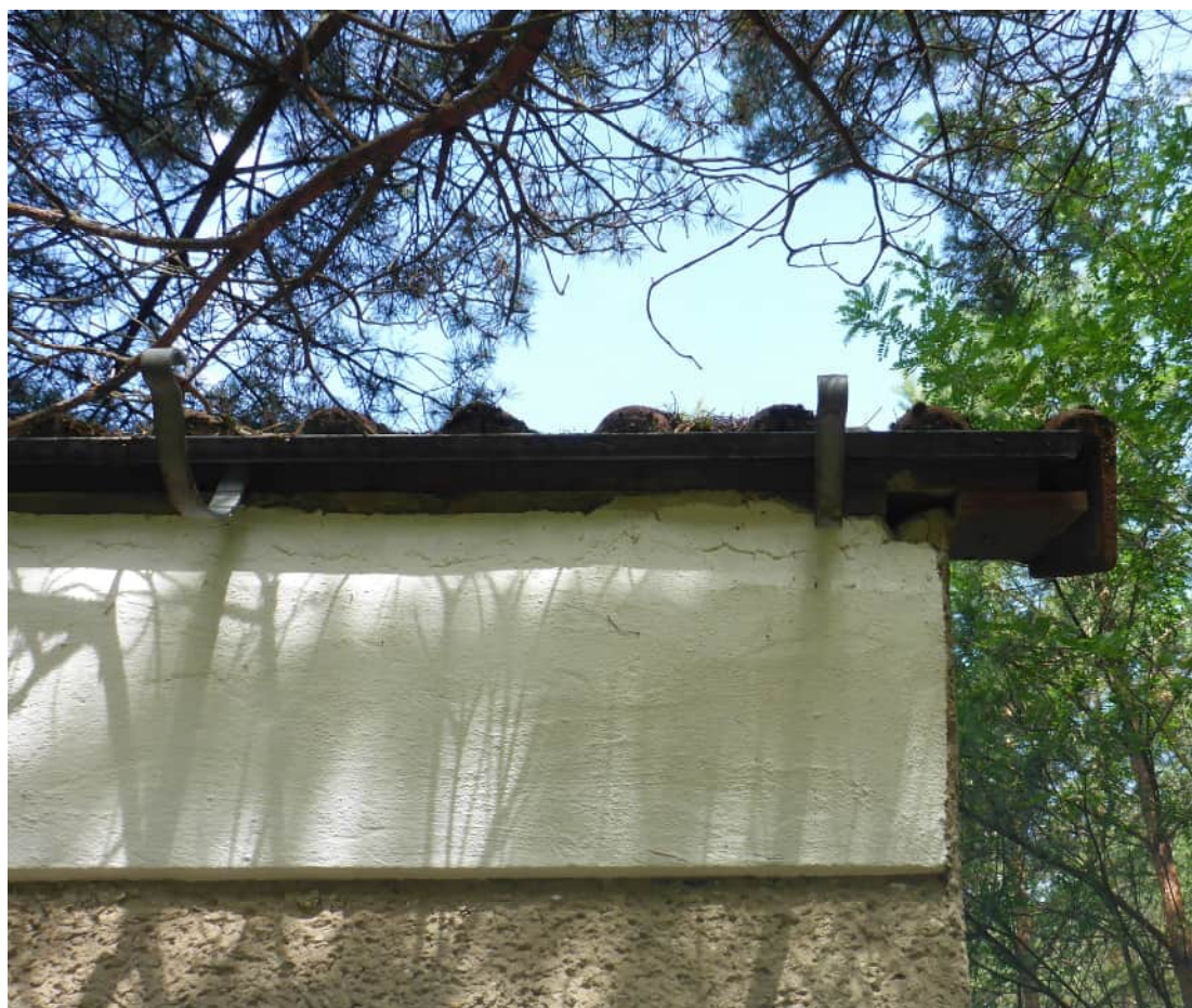
Abbildung 19: Potenzielle Quartiermöglichkeit zwischen Dach und Mauerwerk, Gemarkung Mückendorf, Flur 3 FS Teupitzer Weg Hausnr.
