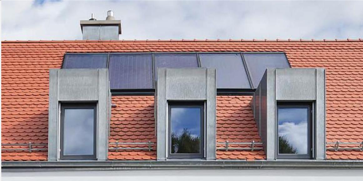
Bei Dächern mit Gauben oder Dachfenstern Orientierung an deren Maßen, so dass sich eine Einheit bildet.
