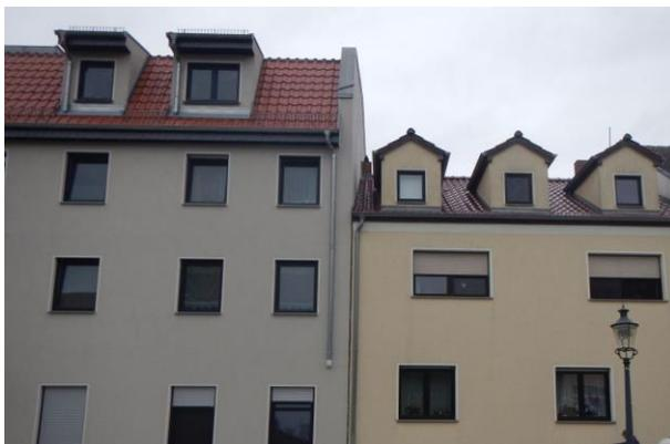
Abb. 16 Störung durch überdimensionierte Gauben
